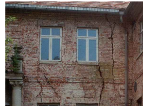
Gebäuderisse in Folge von Setzungen
