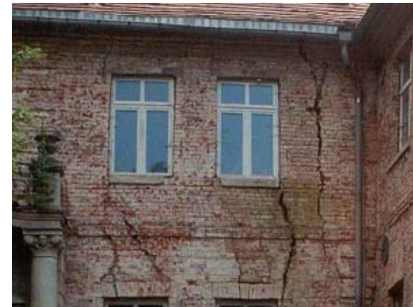
Gebäuderisse in Folge von Setzungen
